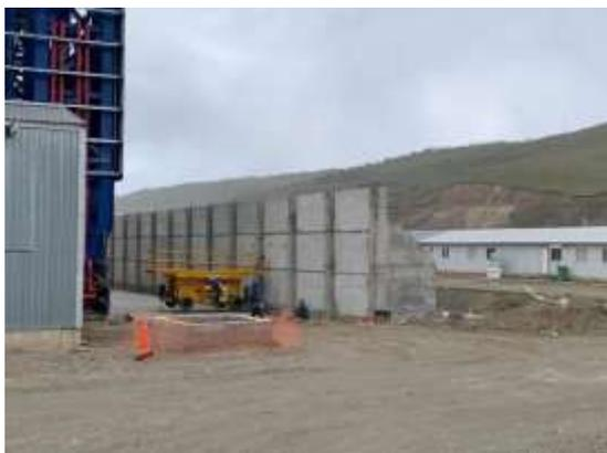
**Imagen N° 71.** Muro de defensa en construcción
