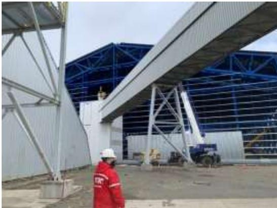
**Imagen Nº 63.** Cinta transportadora y depósito de carbón
