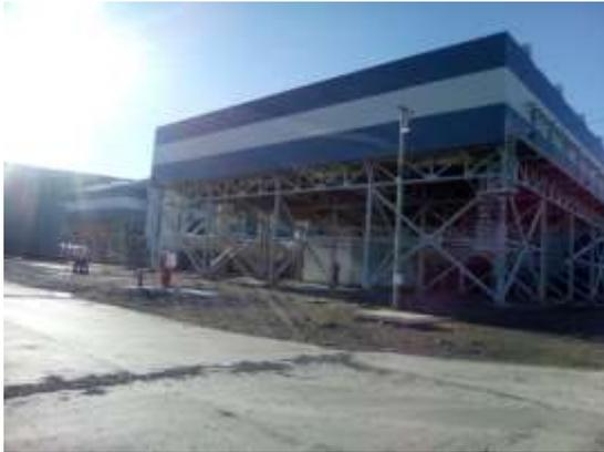
**Imagen N° 7.** Aero condensador de vapor
