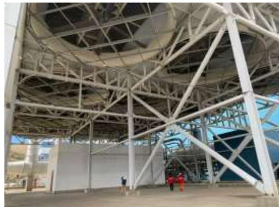
**Imagen N° 10.** Detalle ventiladores de aerocondensador
