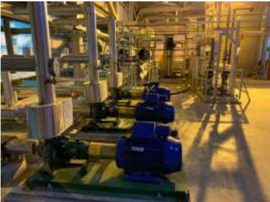
**Imagen N° 83.** Dpositivos de control de aditivos en planta de tratamiento de agua
