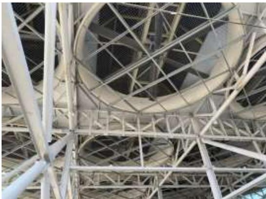
**Imagen N° 9.** Detalle ventiladores de aerocondensador
