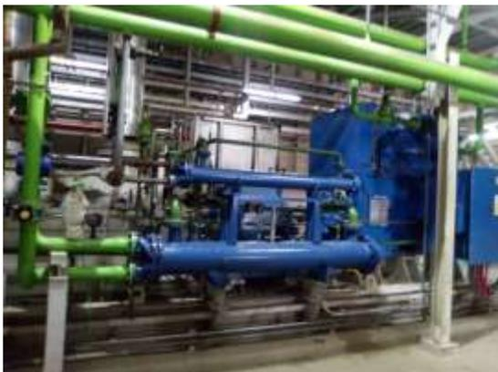
**Imagen N° 41.** Circuitos de presión y enfriamiento
