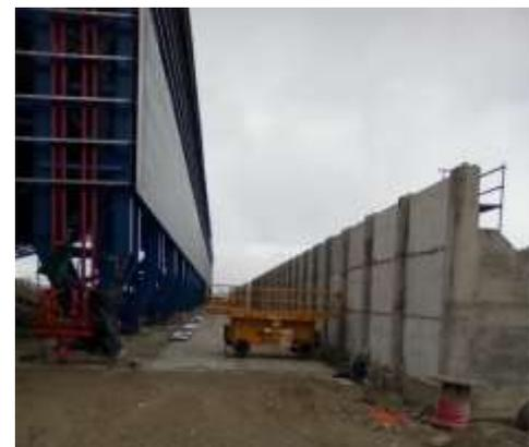
**Imagen N° 72.** Muro de defensa en construcción
