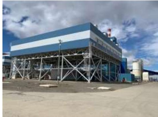
**Imagen N° 8.** Aero condensador de vapor
